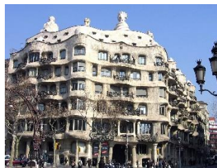
Antoni Gaudí: Kuća Milà , 1910., Barcelona
